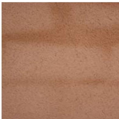
On désigne généralement par le terme de **SPECTRE (ou de FANTOME)** l'apparition du « dessin » des joints de hourdage des éléments de maçonnerie à travers l'enduit de façade (en général à base de liants hydrauliques ou aériens).
